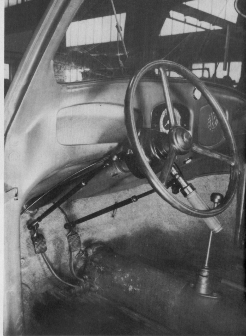
Armaturenbrett und Fußraum des Invalidenfahrzeugs (Typ 67), das durch Umbau einer regulären KdF-Limousine entstand. Baujahr 1939.
